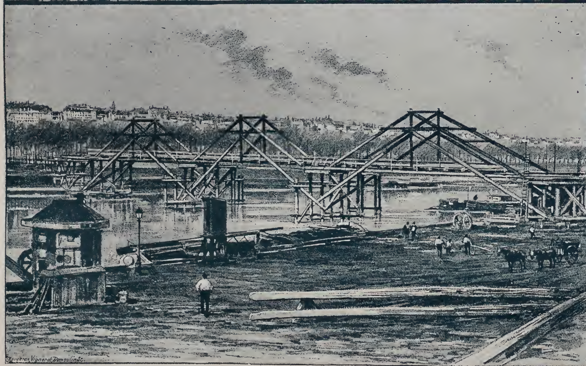
TRAVAUX DE BEIGES POUR L'ÉTABLISSEMENT D'UN QUAI. PASSERELLE PROVISOIRE SUR LE GRAND BRAS DE LA SEINE.
